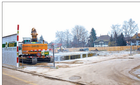
GROSSPROJEKT Im März beginnen die Arbeiten für den Migros-Neubau. SSR
