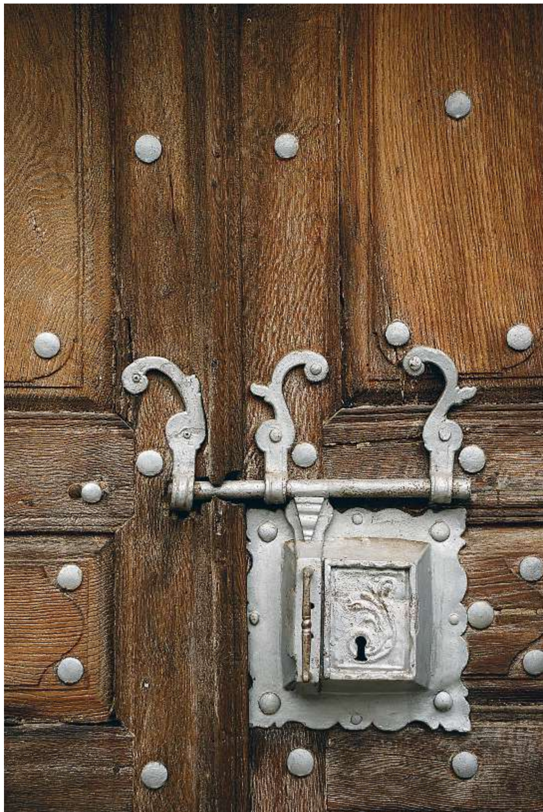
Diese Tür ist geschlossen. Eine Aussen- und viele Innentüren sind Fluchtwege und stehen deshalb offen. Robert Grogg
