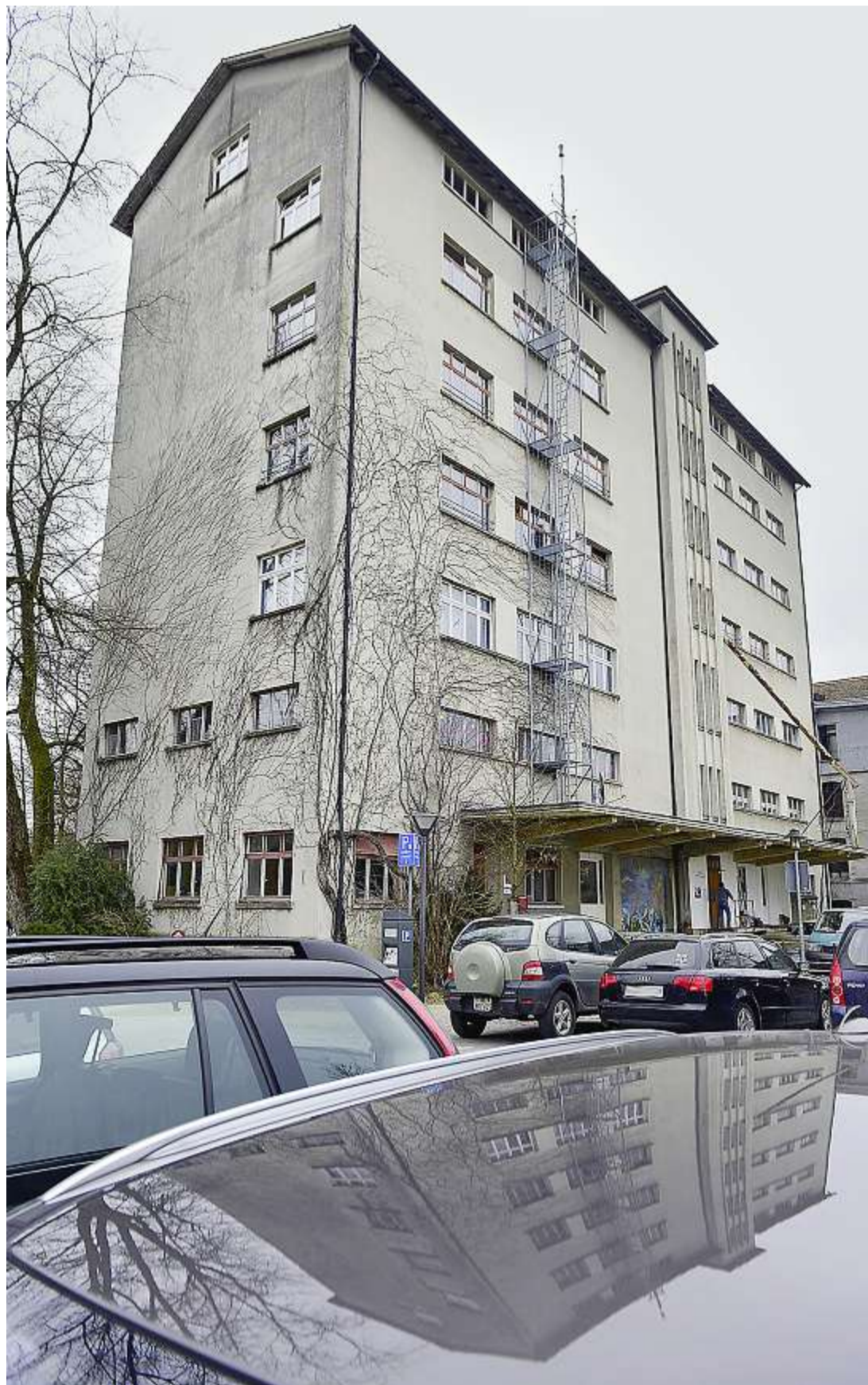
Stillstand rund um das Silogebäude auf dem Langenthaler Mühleareal: Die planerischen Grundlagen für ein Stadtarchiv an diesem Ort werden auch in diesem Jahr nicht erarbeitet.
