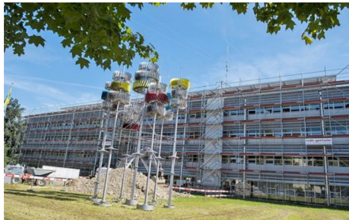
Äusserlich war die Stadtverwaltung im letzten Halbjahr im Umbau. Nun werden auch die inneren Strukturen revidiert.
