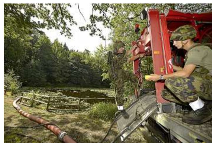
Hilfe vom Militär: Rekruten pumpen derzeit den Schmittenweiher leer. Anschliessend soll der undichte Staudamm saniert werden.
